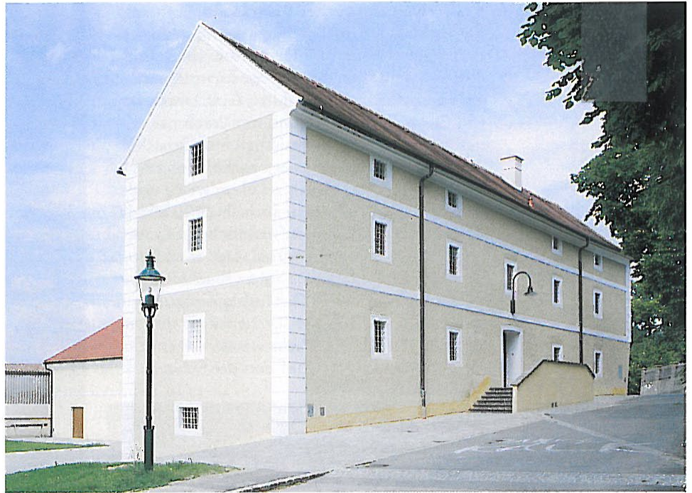
Schüttkasten in Ebenthal, Straßenseite nach der Renovierung
